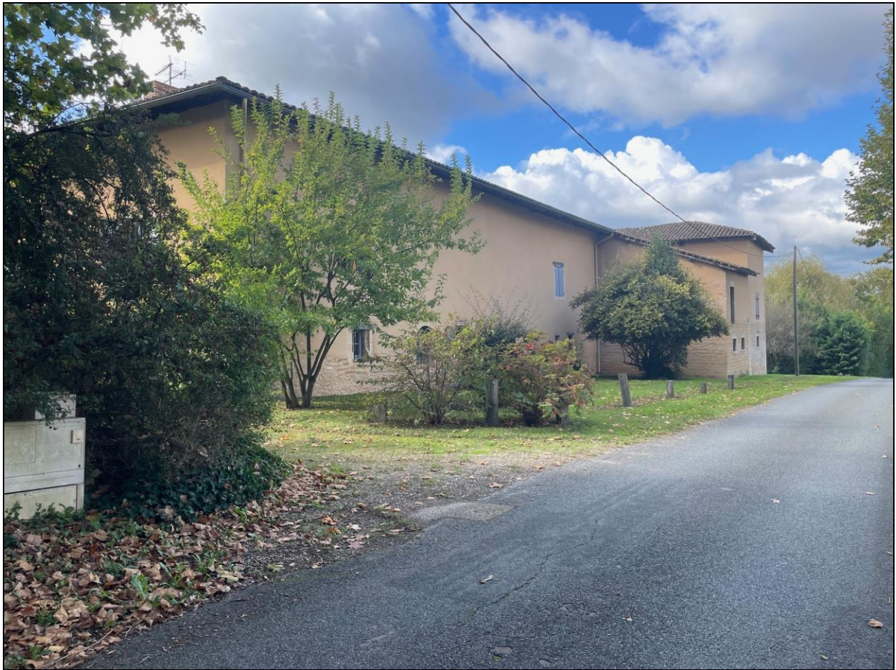
Fareins, maison dit du "Passeur", 2024 (source : Manon Descombes)
